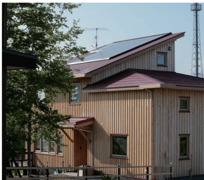
写真上/西條兄弟が手がけている住宅に採用されている外断熱の構造。左から順に、木の外壁、木質系繊維の断熱材、そして古新聞紙をリサイクルして作られたセルローズファイバー断熱材。自然系断熱材を2層にすることで、エネルギー消費を少なくする工夫がされている。写真下/エコビレッジの中に建てられた建物のひとつ。外壁は道南杉を無塗装で使用、屋根はボルドーレッドで統一。
