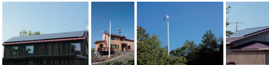
伊達市のエコビレッジに建つ2棟の住宅にはソーラーパネル、風力発電などが設置されている。
