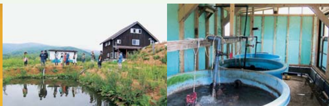
浄化池とBMWのポンプ小屋(このときはまだ外貼りが未完成)。
