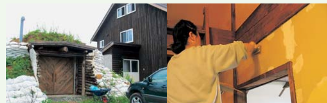
母屋とつながる野菜貯蔵用の丘室。セルフビルドでほとんど奥さんが仕上げた珪藻土の壁仕上げ。
