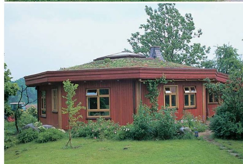
屋根緑化されたゲストハウス
