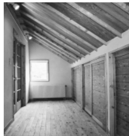
自然素材を使った屋根裏部屋のリフォーム
