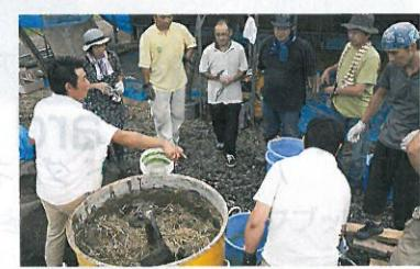
▲この日の素材は土、砂、大小2種類のわら、水に強度保持のセメントを4%。「土の柔らかい表情を壊さないギリギリの割合です」
