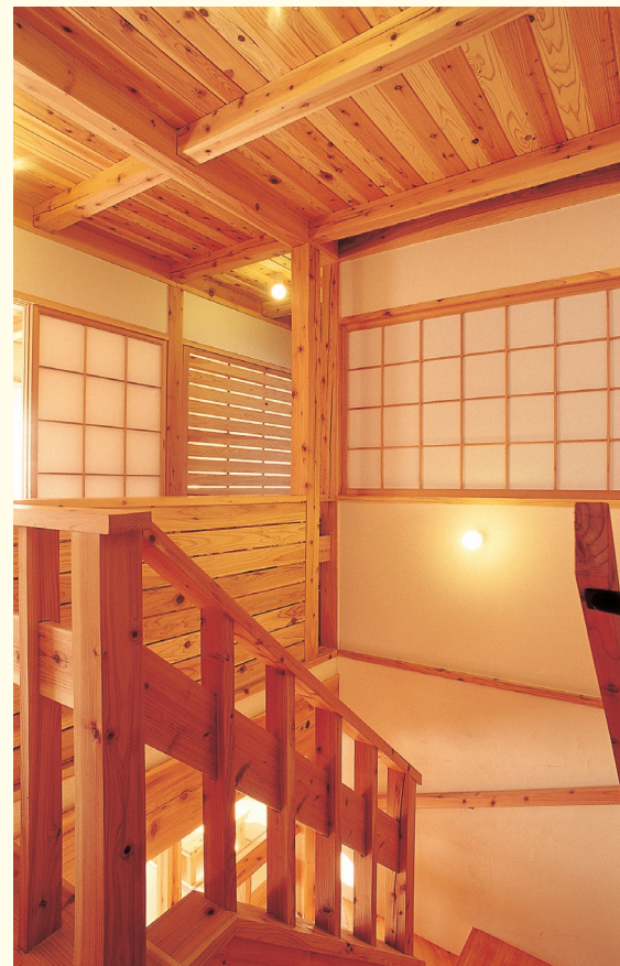
▼居室部分は床や天井すべてに杉を使った。
