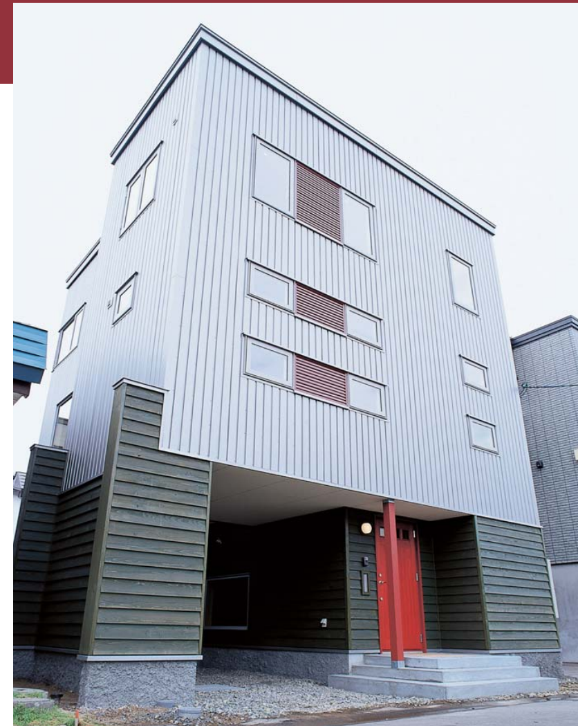
外壁はガルバリウム鋼板と、道南スギの下地板をドイツ・リボスの自然塗料で仕上げたもの。 駐車スペースには、生活排水を利用したランニングコストゼロの簡易融雪槽を設置。
