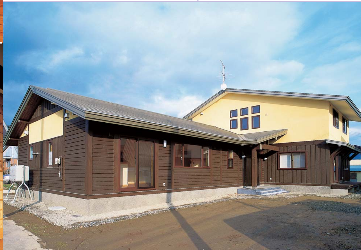
道南杉の下見板は建主さんがメンテナンスできるように1階レベルまでとし、2階外壁は道産珪藻土で仕上げている。
