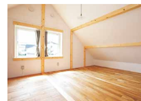
梁の補強と断熱工事を施し三角屋根を生かした2階居室はスギの香りがほのかに気持ちいい。
