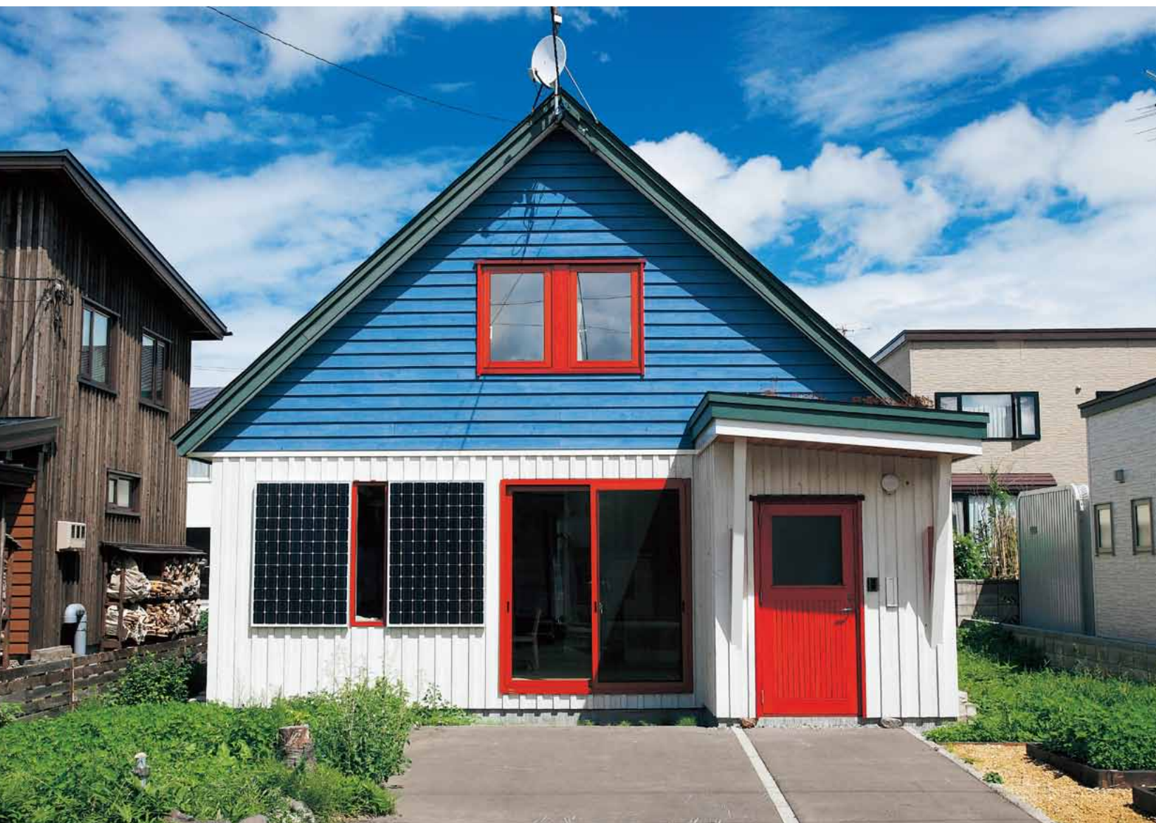
外壁は道南スギをカラーリングした、かわいらしい木の外観。壁には500Wの自家発電用ソーラーパネルを設置。
