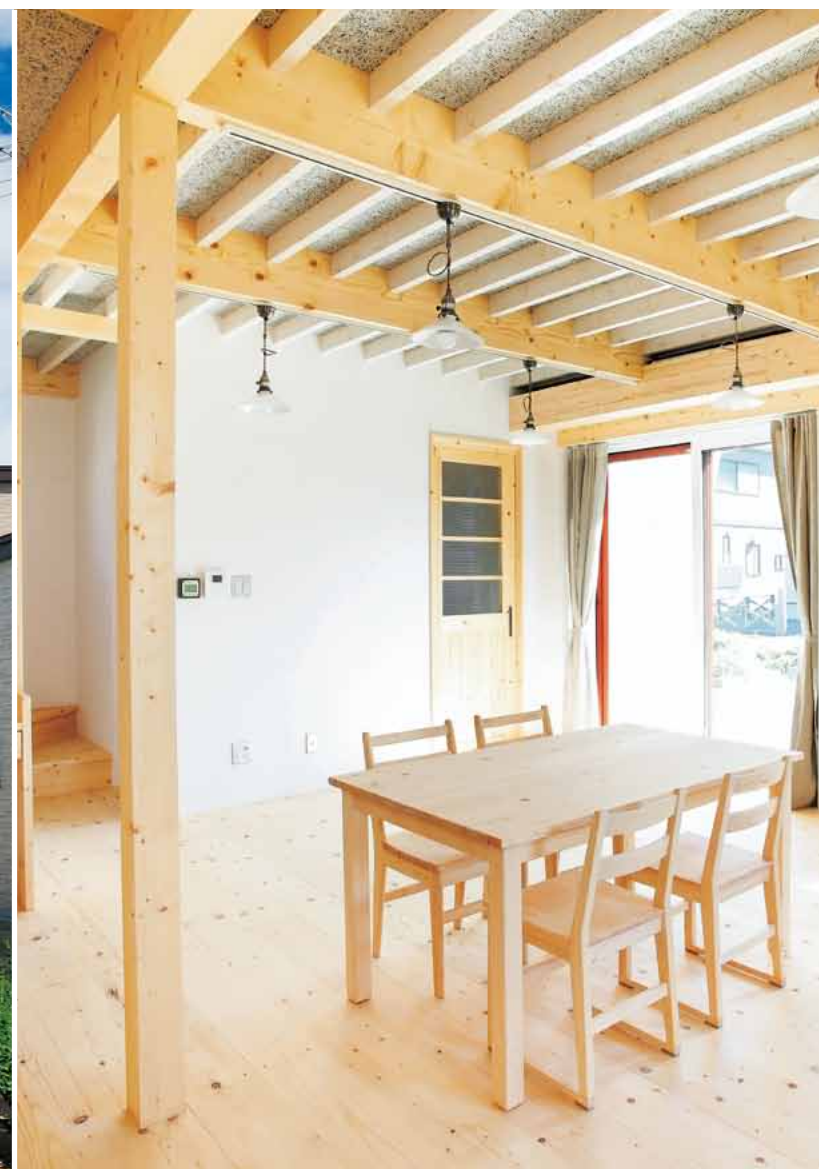
トドマツの幅広床板と木毛セメント板の天井、コンクリートブロックの壁を表し自然素材のラフな素材使いがお洒落。
