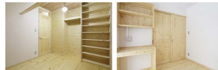
左/2階の個室は均等に4分割、クローゼット収納と本棚が間仕切り代わり。 右/1階の個室に仕事用の机を造作しました。
