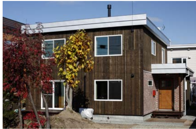
コンクリート住宅が木の温もりあふれる住まいに変身。躯体は生かし、玄関の位置や間取りの変更で家族のライフスタイルに合った住まいに。
