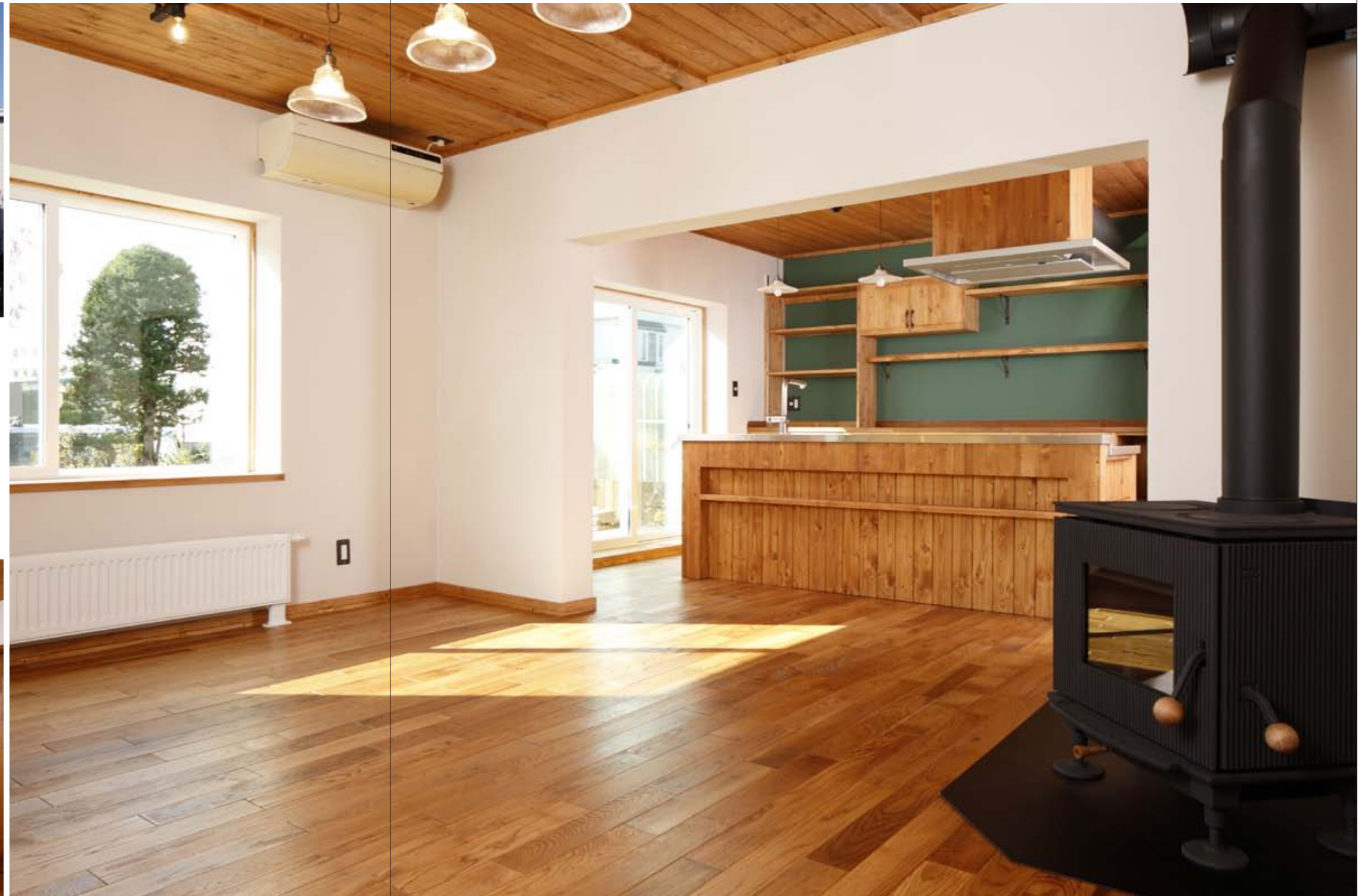
北海道産の無垢の木と帆立貝の漆喰で仕上げたナチュラルなインテリア。 床は元のコンクリートの上に厚さ20mmの木質断熱ボードを敷き、その上にミズナラのフローリングを施工。
