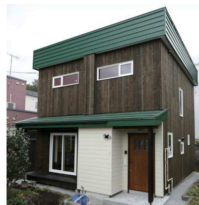
標準仕様の木酢液を浸透させた道産カラマツの板壁仕上げ
