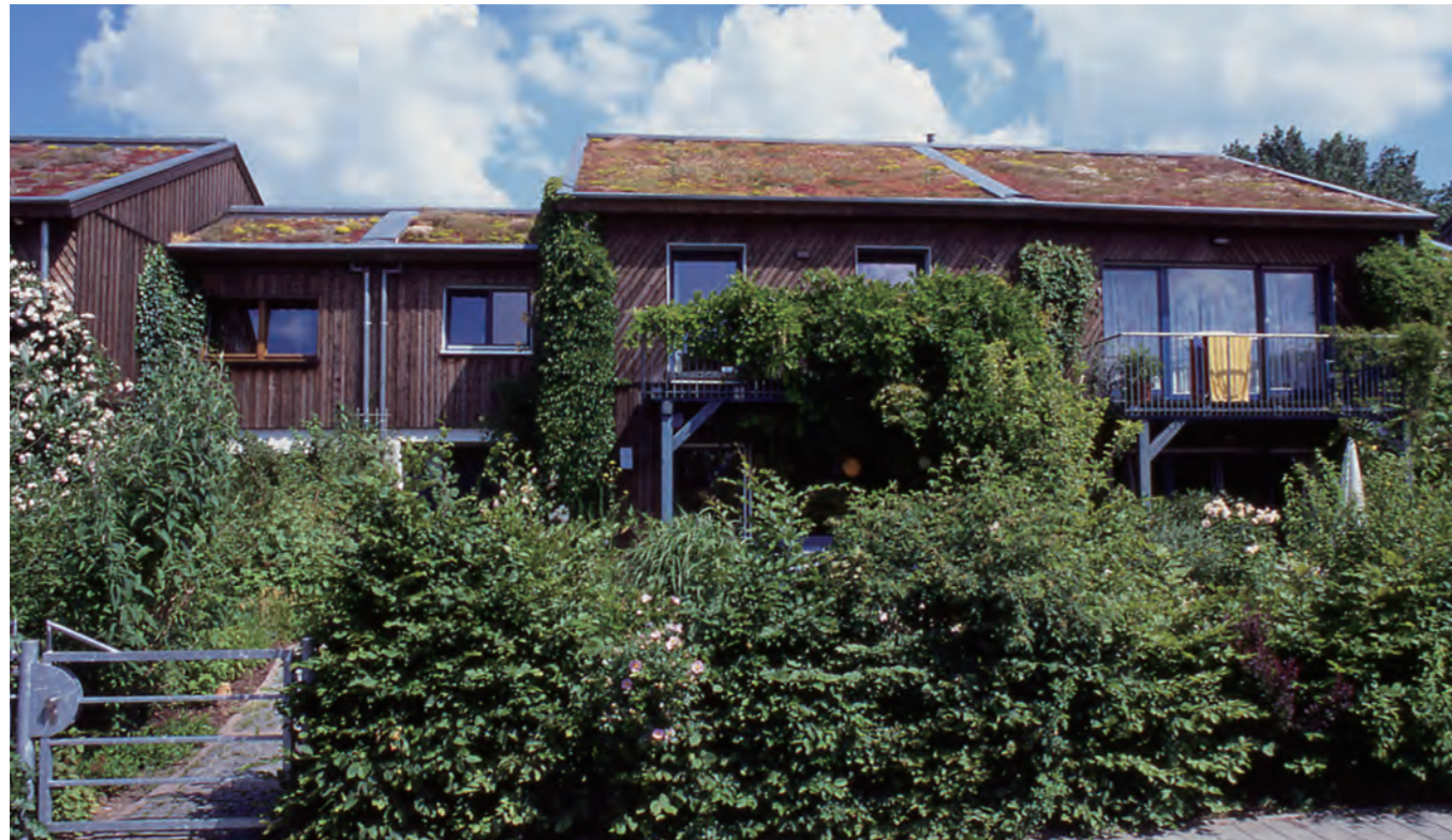
ドイツ・ダルムシュタットのエコロジカル団地内に建つ連棟長屋式住宅 木の板壁に高山植物の草屋根を乗せ、誰が見てもすぐにナチュラルハウスとわかるデザインだ
