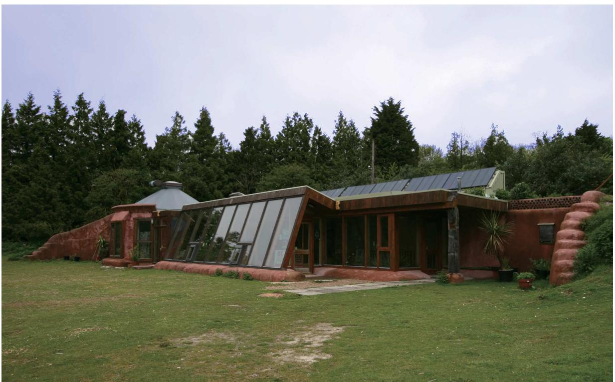
左右の土留めには古タイヤやガラス瓶を積んだ壁が、土の屋上には設置されているソーラーパネルが見えます
