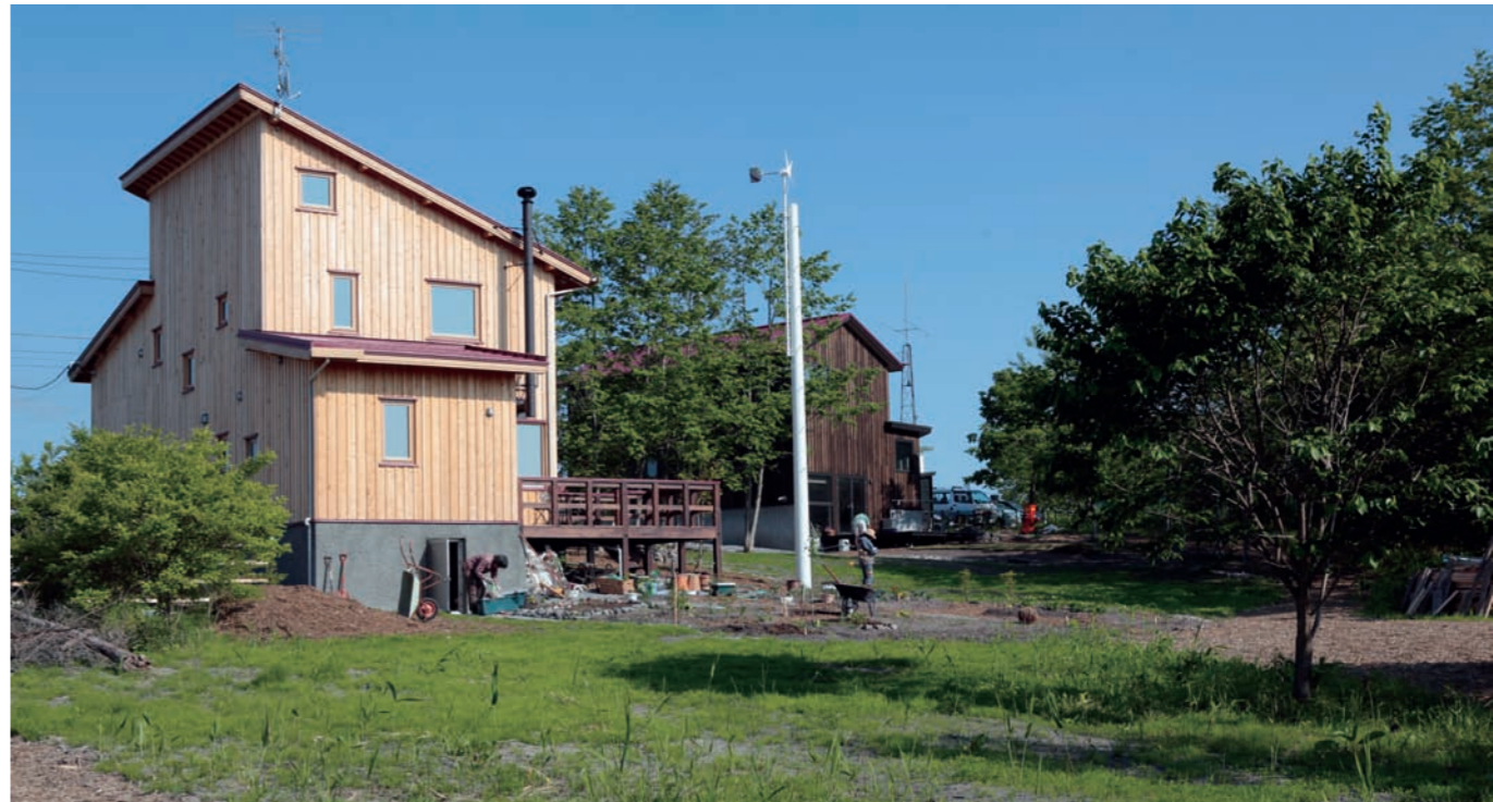
敷地の西の端から村全体を見渡す。すでに、2軒の住宅が建てられている。
