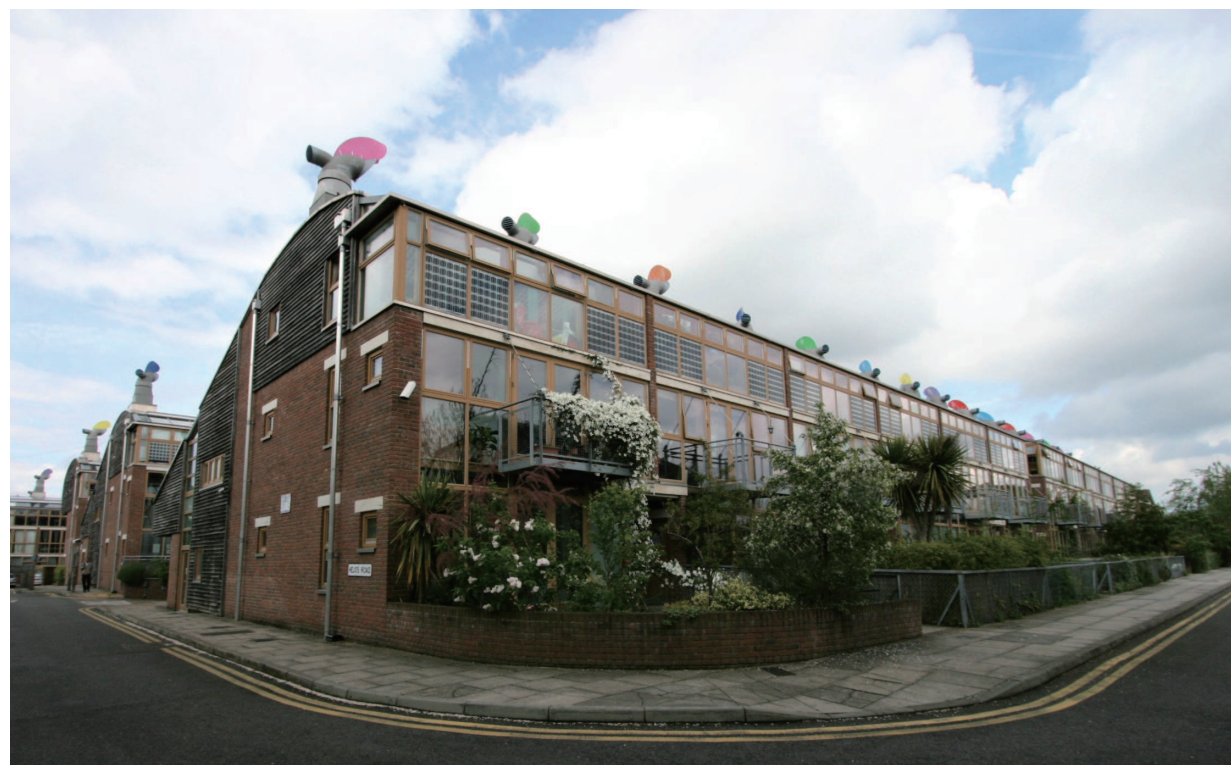
カラフルな空調用のカウルをのせた建物がまるで倉庫群のように並んでいる『Bed Zed』の住棟
