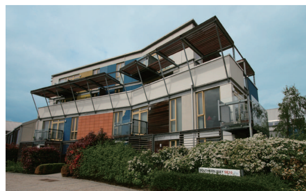
低層プレハブ建築の建物も隣接している。
